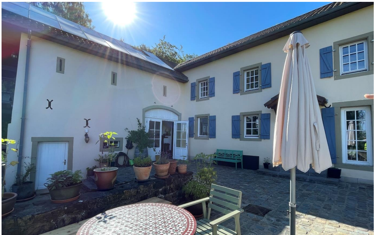
Abbildung 12: Bestehendes Gebäude und Hof/Einfahrt der „Eppeltree hideaway cabin“. Quelle: Oeko-Bureau, 2024.
