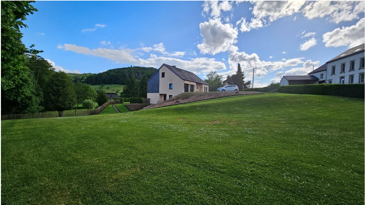
Abbildung 12: Zentraler Bereich des VB mit Sicht zum angrenzenden Wohnhaus im Südwesten
