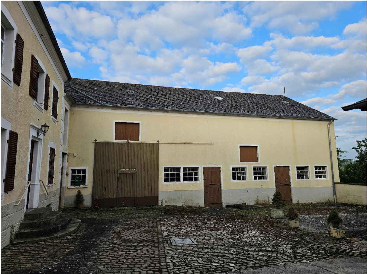
Abbildung 6: Scheune im Norden des VB, nördliche Gebäudeansicht mit angrenzendem Wohngebäude
