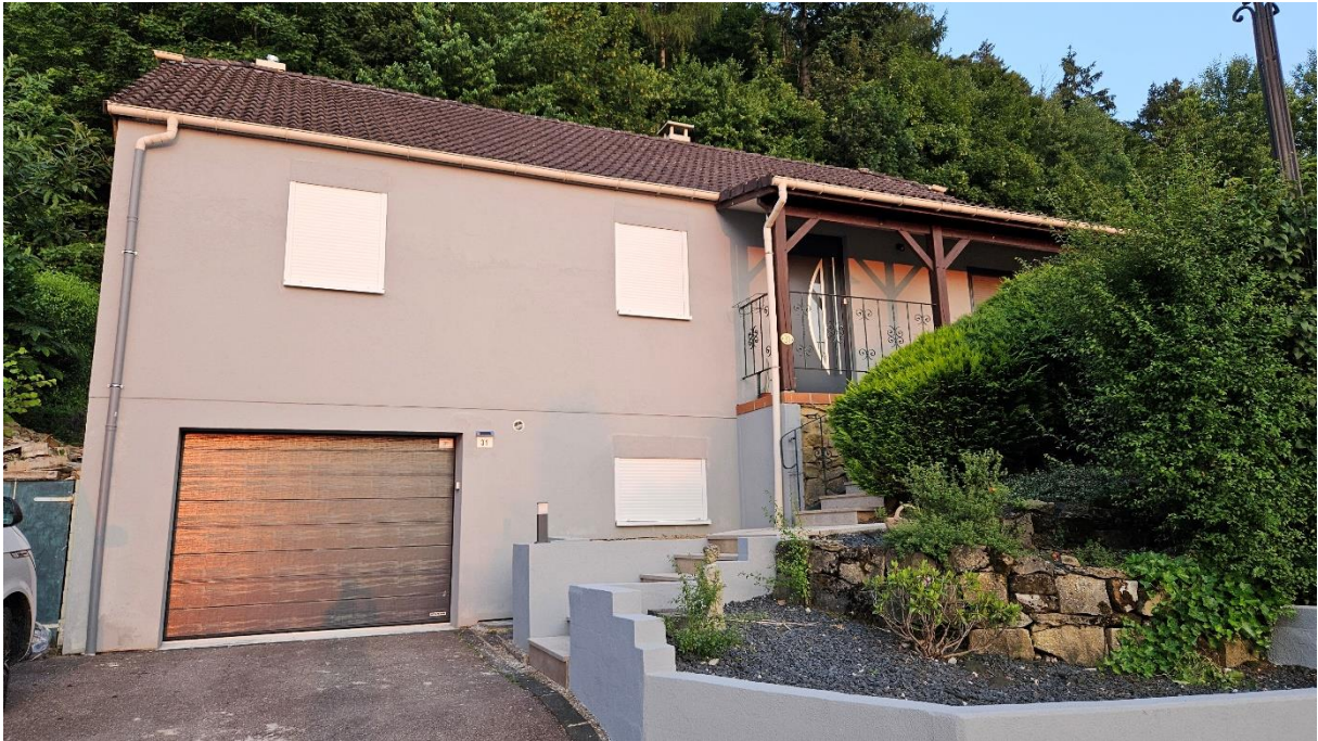
Abbildung 18: Wohngebäude im Norden des VB, westliche Gebäudeansicht
