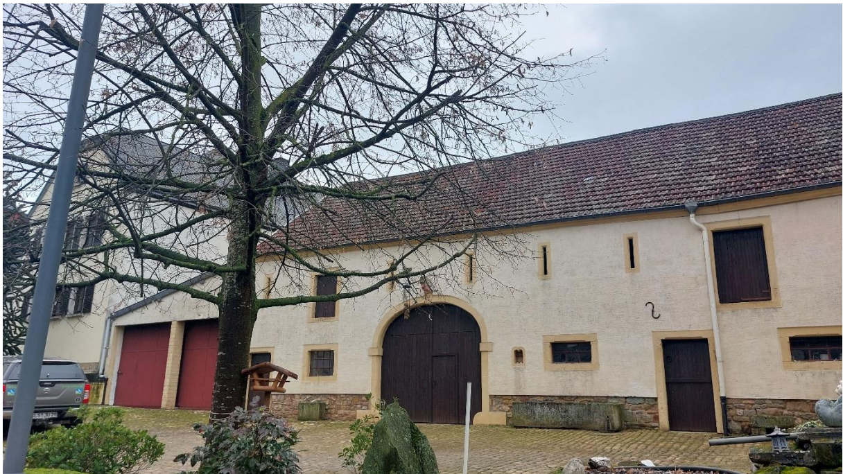
Abbildung 28: Hofgebäude angrenzend zum Wohngebäude
