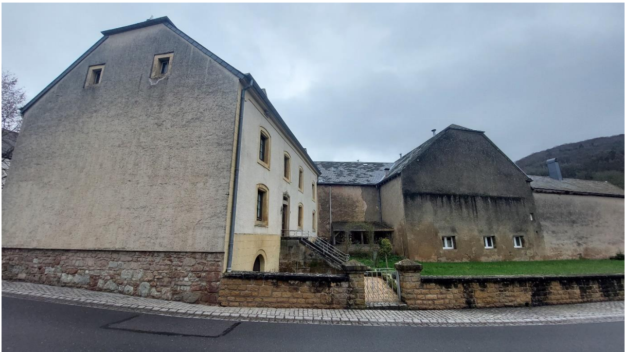
Abbildung 30: Östlich angrenzenden Gebäude
