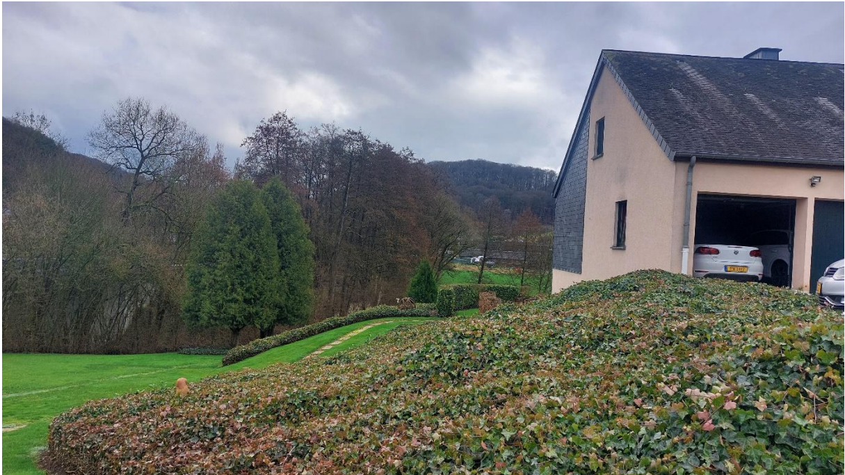
Abbildung 46: Vorgarten mit Wohngebäude, Blick nach Süden
