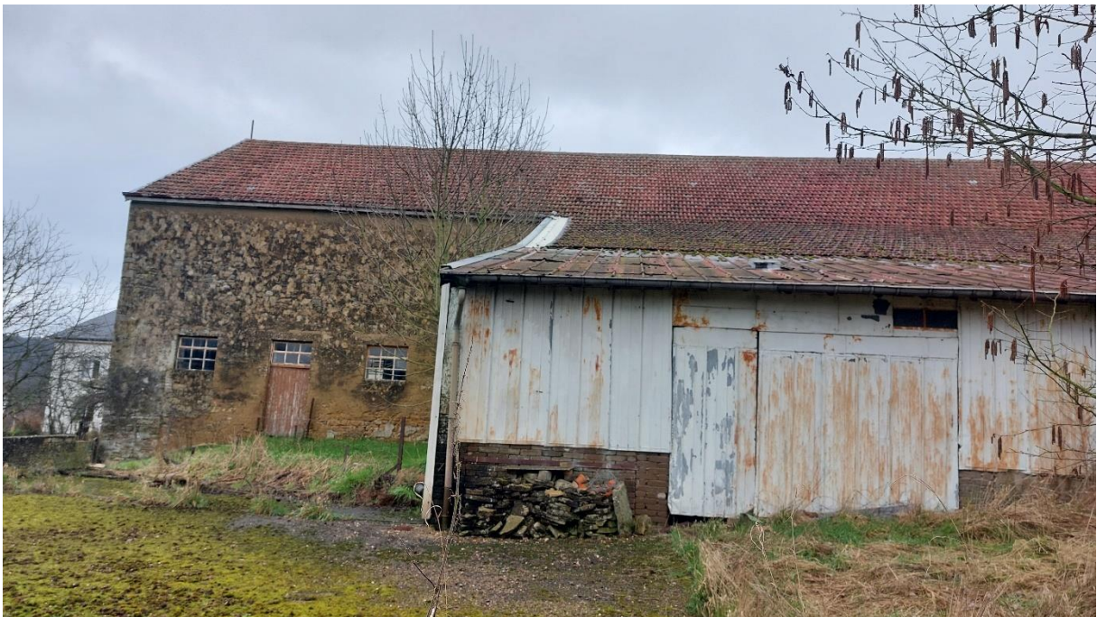
Abbildung 14: Hofgebäude mit angrenzendem Schuppen
