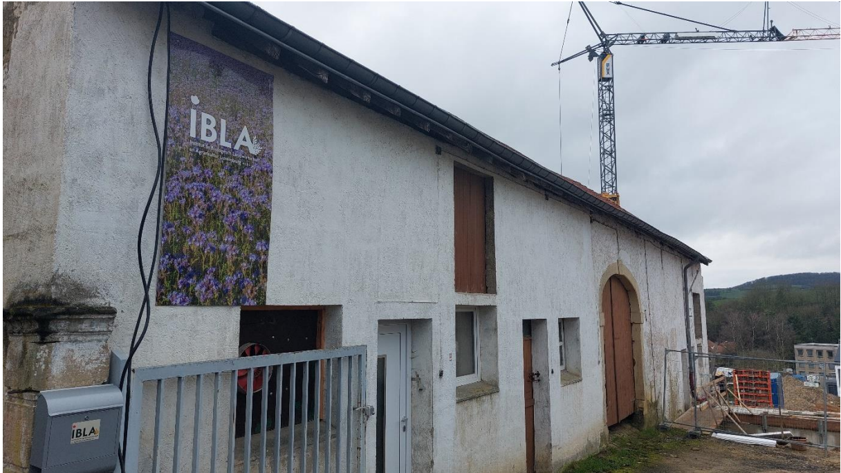
Abbildung 56: Hofgebäude im Osten (der IBLA Luxemburg) mit Sicht zum Bereich, wo ehemals eine Scheune stand (bereits abgerissen)
