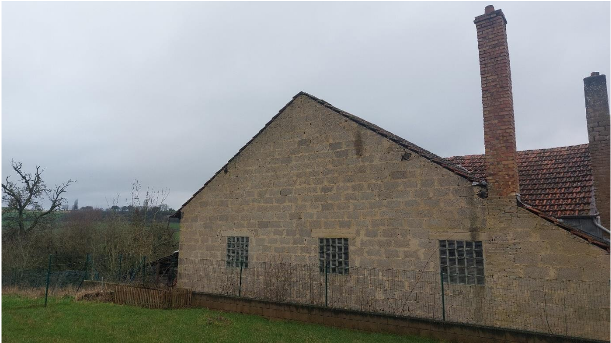
Abbildung 15: Östliche Ansicht des Hofgebäudes
