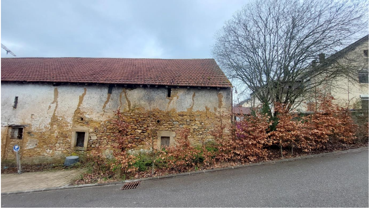
Abbildung 58: Hofgebäude mit Heckenstruktur
