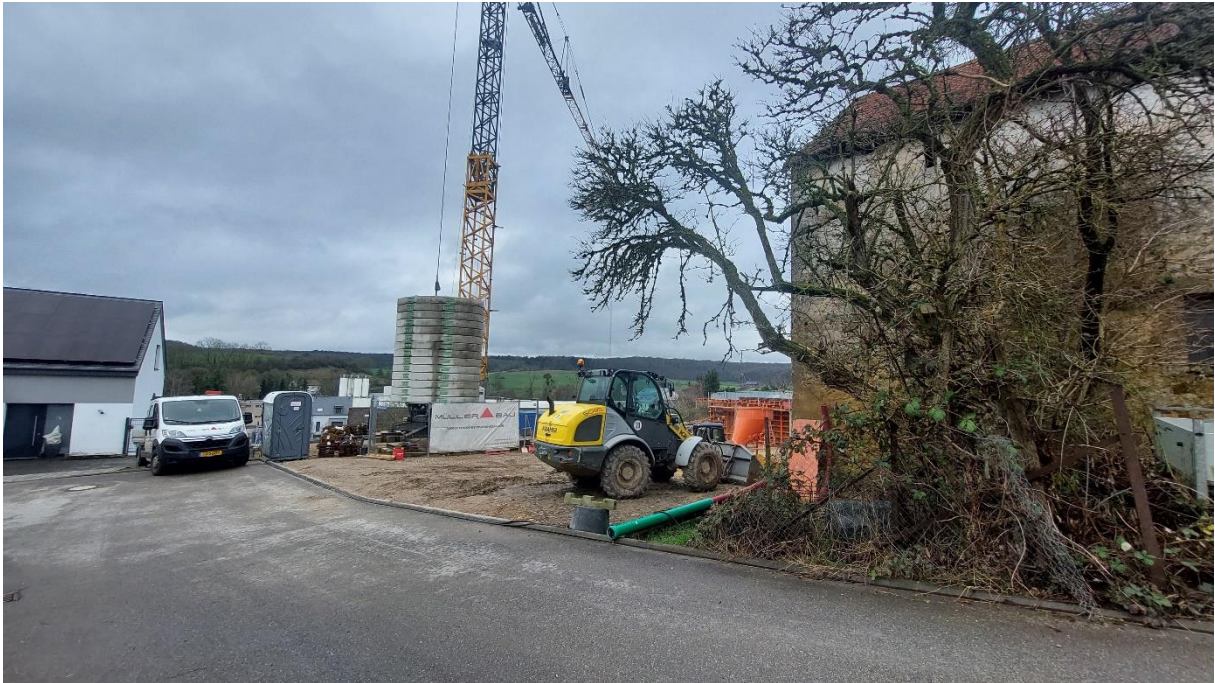
Abbildung 60: Sicht zum westlichen Bereich des UG, ehemalig Grünland und jetzige Baustelle
